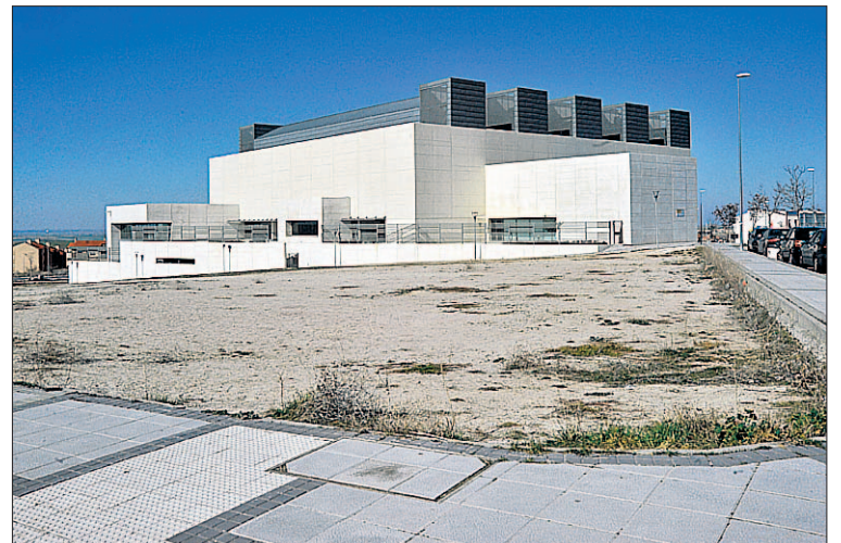
Parcela, junto a la Biblioteca, donde se levantará el centro de AFA. / KAMARERO
