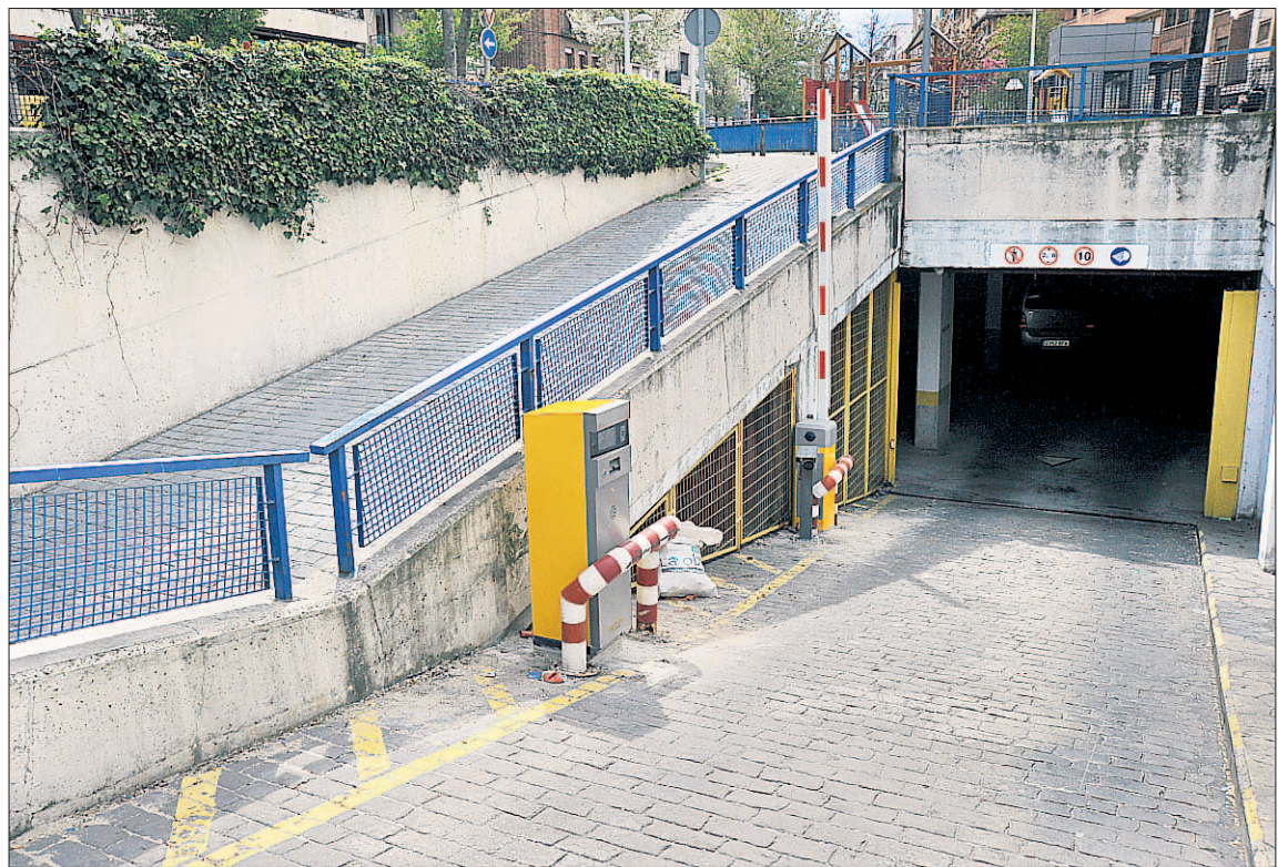
Acceso al aparcamiento subterráneo en la plaza de José Zorrilla de la capital segoviana. / KAMARERO
