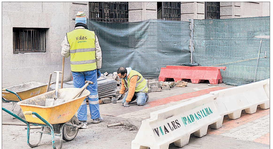
Dos operarios trabajaban ayer en el paso de peatones situado junto al Palacio de Justicia. / KAMARERO
