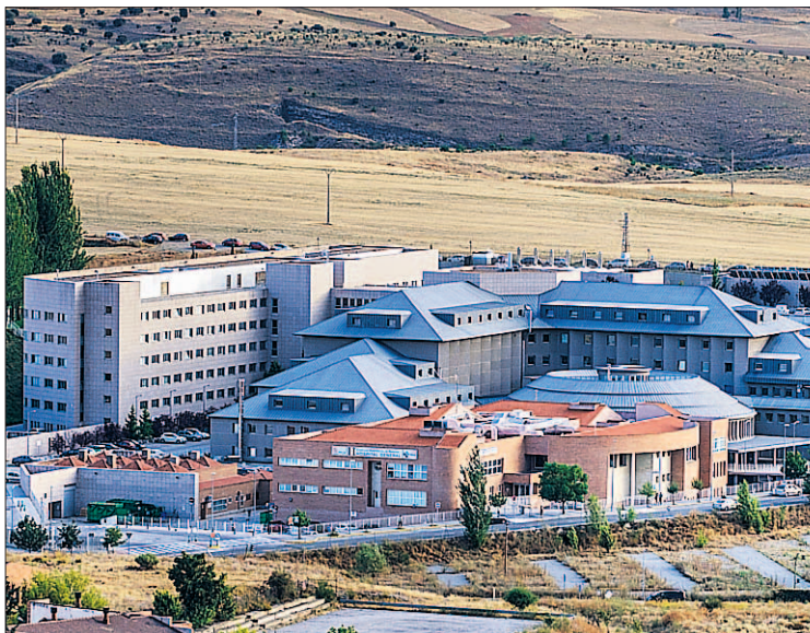
Complejo Asistencial donde se encuentran las consultas y el hospital. / KAMARERO
