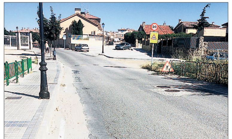
Estado actual de una de las calles que será asfaltada. / EL ADELANTADO
