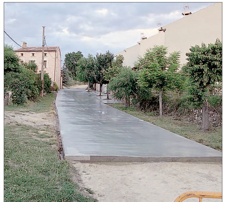
La calle del Molino, que es la que está siendo hormigonada. / EL ADELANTADO
