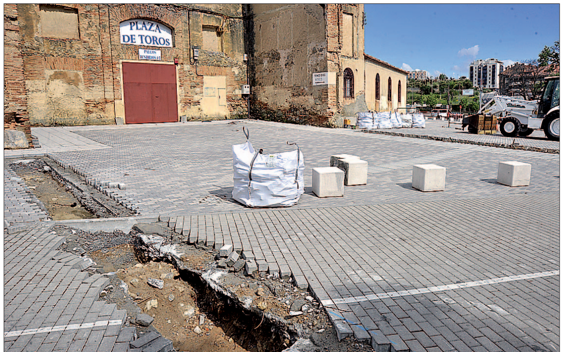
Los trabajos para delimitar la parcela que ocupaba el antiguo edificio se desarrollaron a finales de mayo. / KAMARERO
