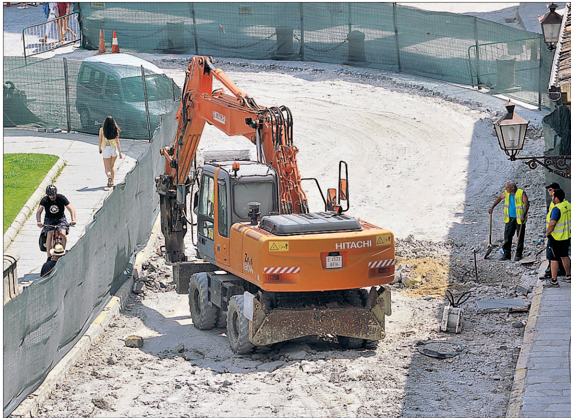
Obras en la calle San Juan. / KAMARERO
