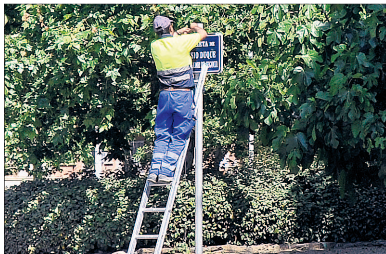
Las placas se han colocado en sentido subida y bajada. / KAMARERO
