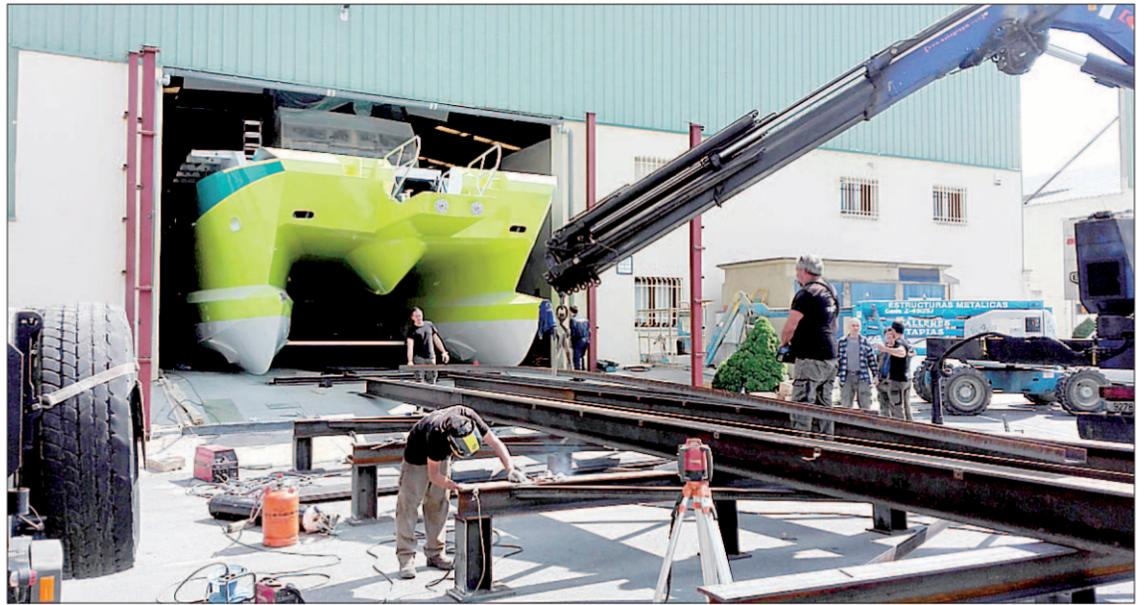
Las primeras labores consistieron en la instalación de raíles metálicos para arrastrar la embarcación hasta el exterior. / F. D.
