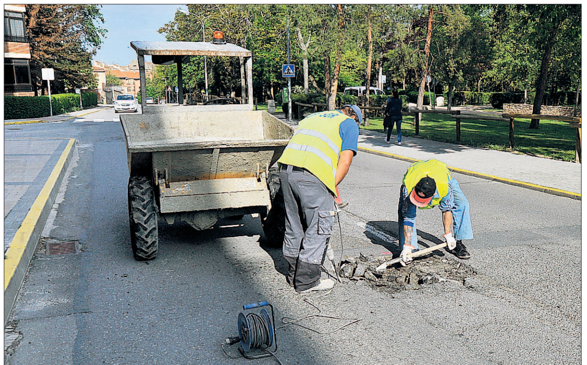
Los trabajos del plan de bacheo del Ayuntamiento comenzaron ayer por la mañana en la calle Bomberos. / KAMARERO
