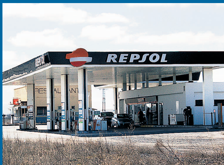
Gasolinera de Martín Muñoz de las Posadas que sufrió el último robo. / F. D.
