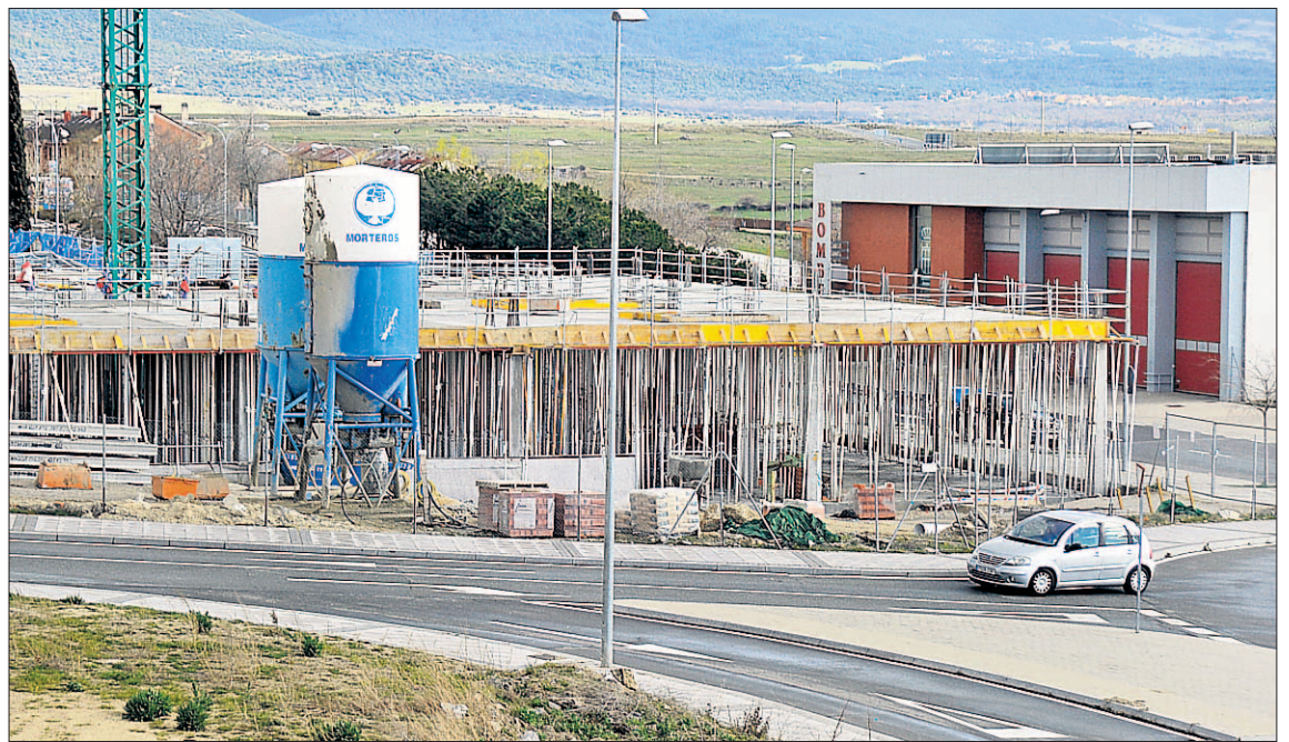
En la actualidad se está procediendo a las obras de la estructura del futuro edificio de juzgados. / KAMARERO
