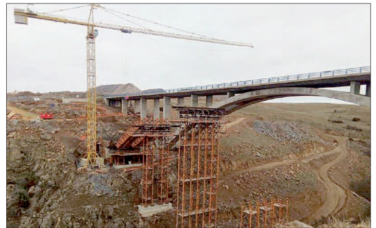
Los trabajos se centran en el nuevo viaducto de la SG-20. / ANGEL VALLÉS
