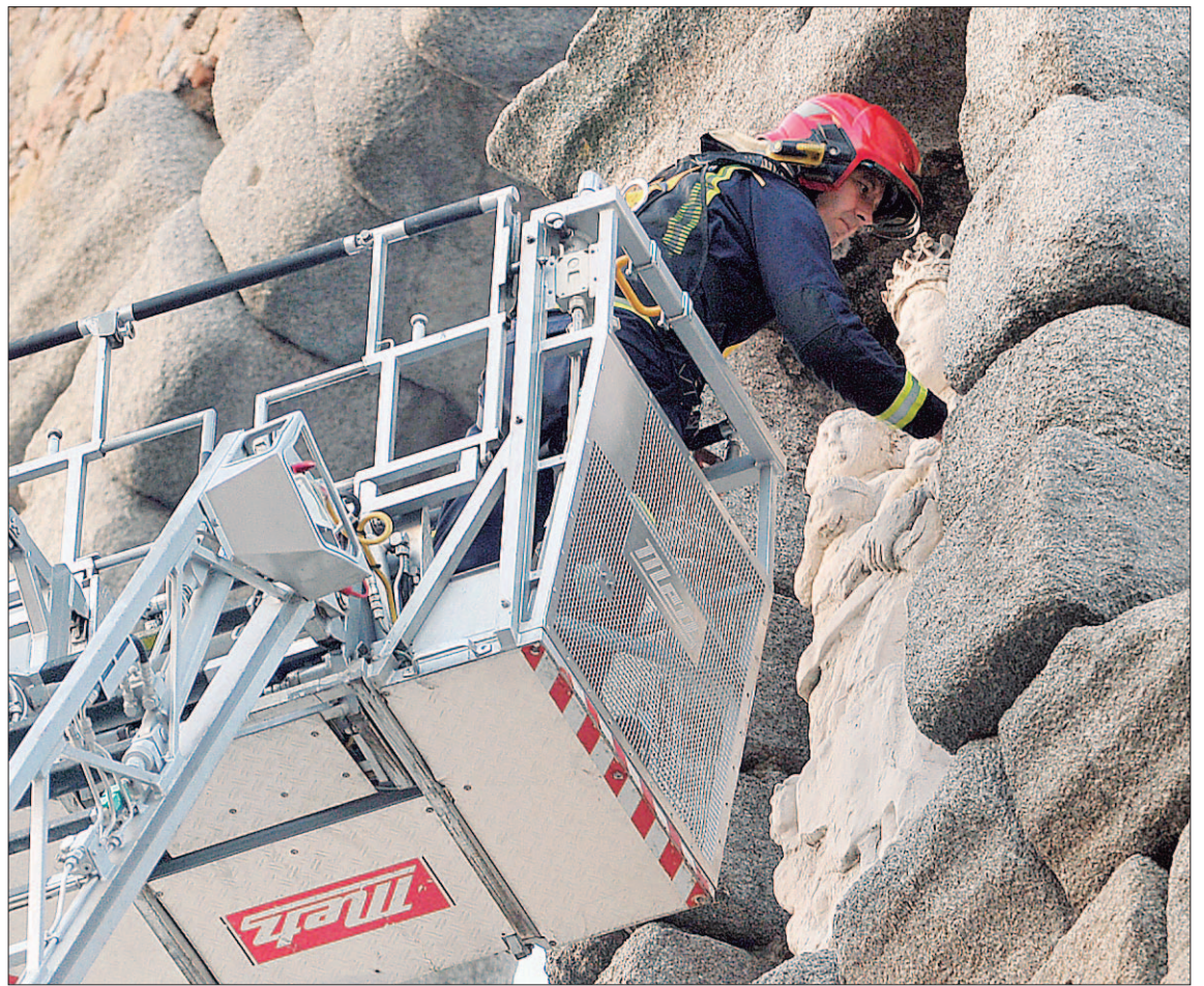
Los bomberos inspeccionaron la imagen tras ser avisados del desprendimiento de un pedazo de la misma. / KAMARERO
