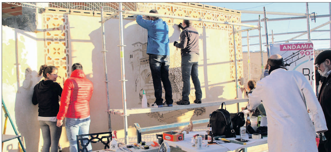
Momentos de la realización de los murales de esgrafiado junto a la iglesia de San Martín. / C.N.
