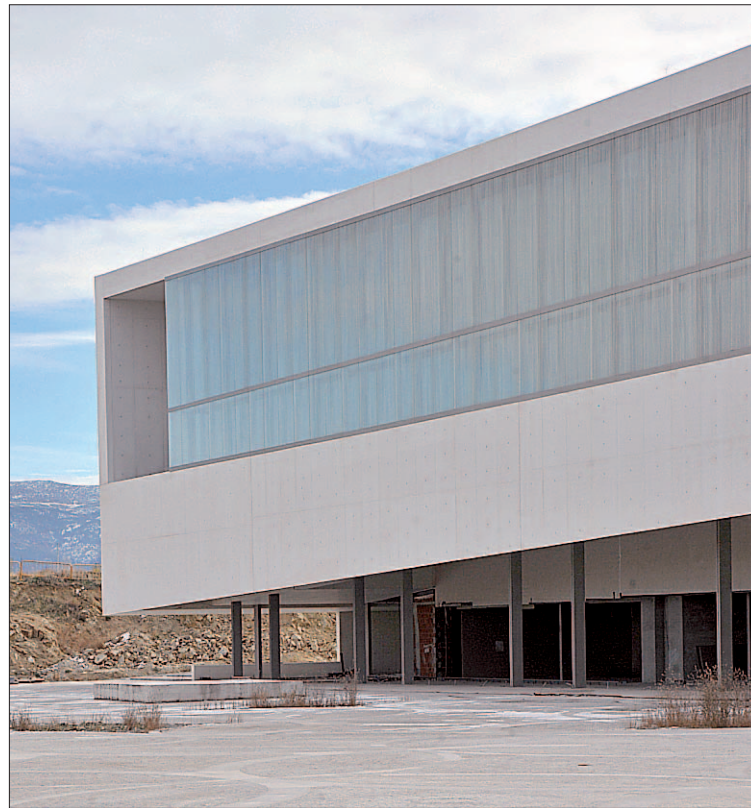
El edificio CIDE, del CAT, aún está sin terminar. / KAMARERO
