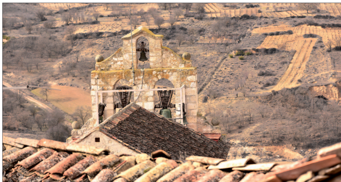
Espadaña de la iglesia.
