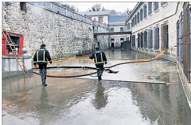
Los bomberos actuaron en el patio tras la inundación de abril de 2013. / KAMARERO
