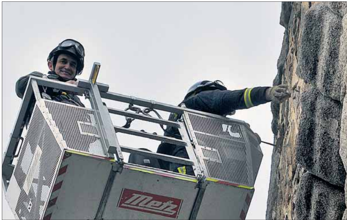
Los técnicos volvieron a revisar ayer la parte monumental del Acueducto, para determinar su estado tras las nevadas. / KAMARERO
