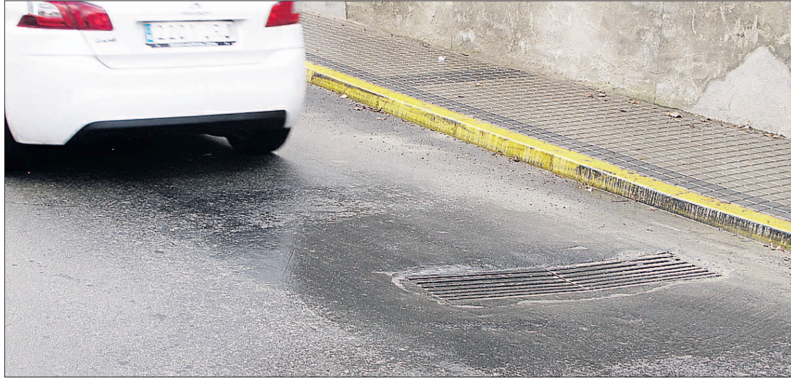
El bache del inicio de la calle Antonio Machado fue reparado provisionalmente el jueves por la tarde. / EL ADELANTADO
