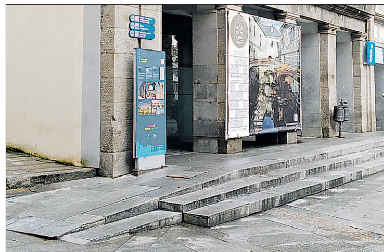
Escaleras y rampa lateral en el acceso al Centro de Recepción de Visitantes. / N. LL.
