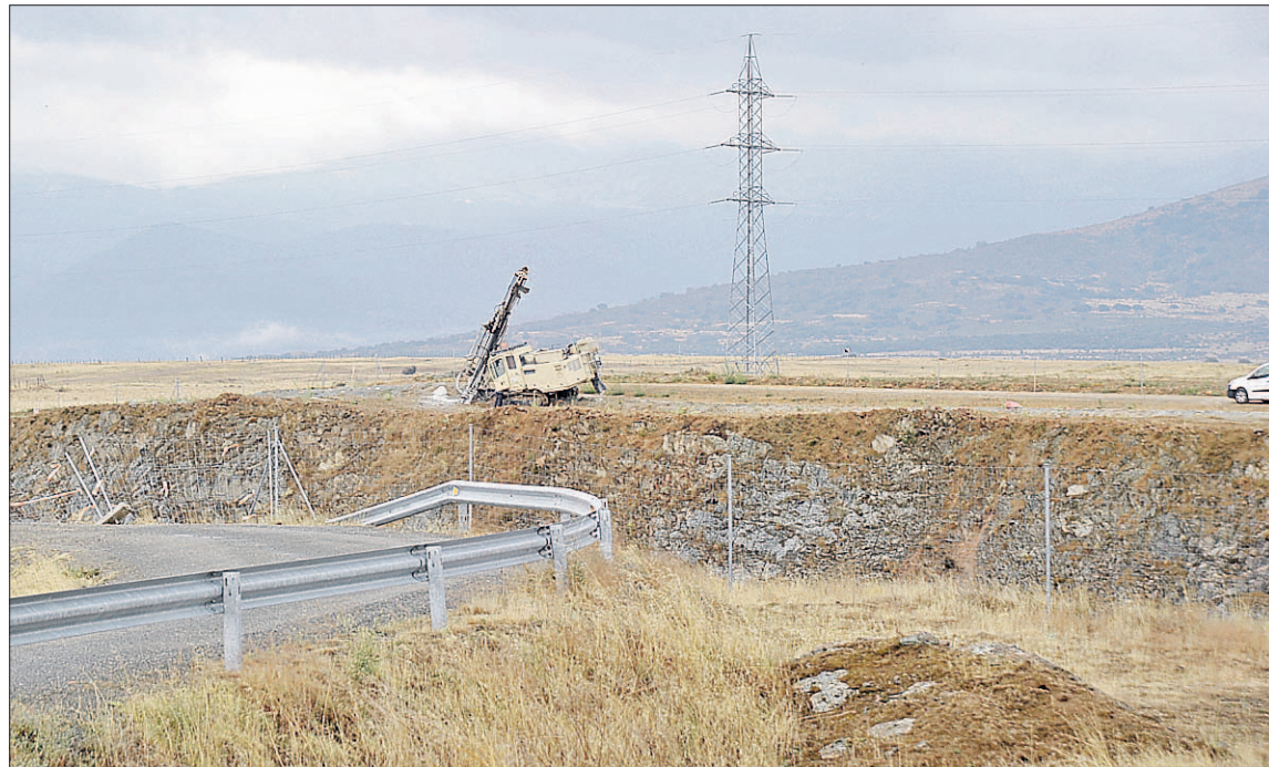
Los operarios llevan meses trabajando en las obras de desdoblamiento de la SG-20. / KAMARERO
