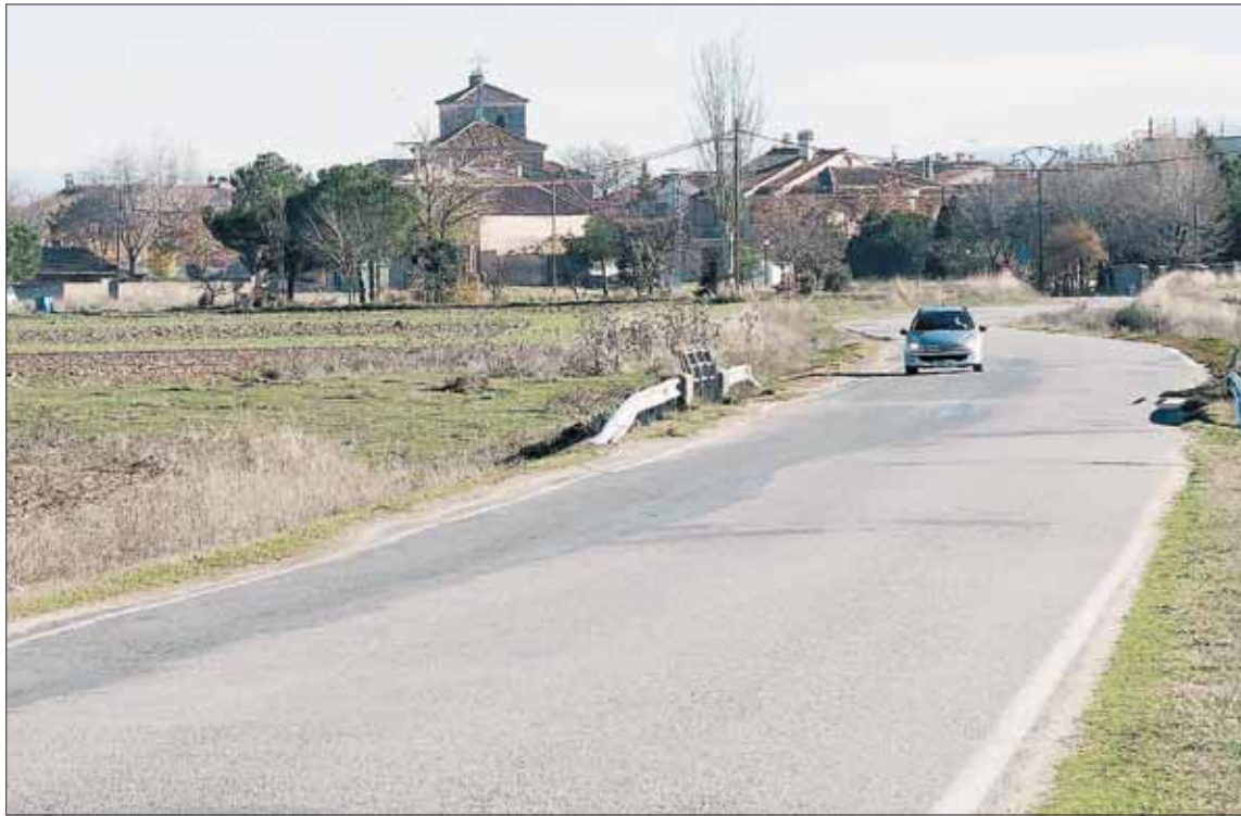
Vista de la carretera de Escarabajosa de Cabezas a la autovía de Pinares que va a ser mejorada. / EL ADELANTADO
