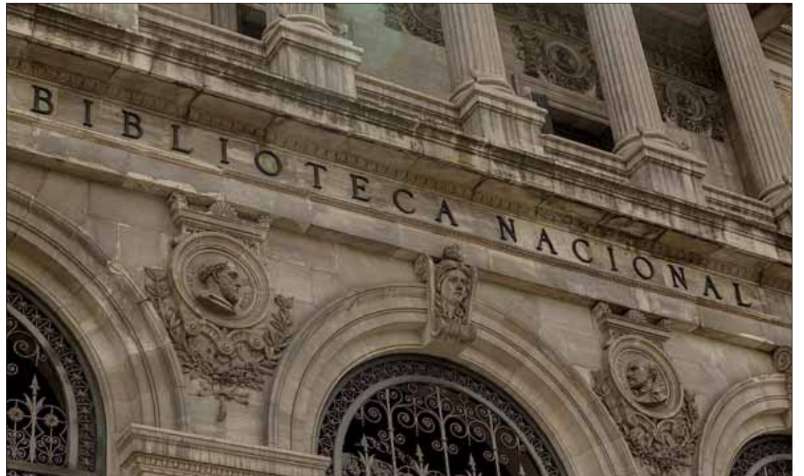
Las fachadas del edificio de la biblioteca se encuentran en un estado más delicado de conservación que otras zonas. / E.P.
