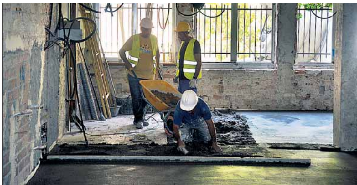
Imágenes de las obras en ejecución en el instituto Andrés Laguna. / KAMARERO
