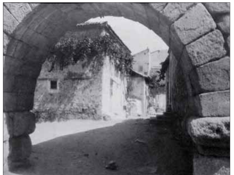
Arco del Acueducto.
