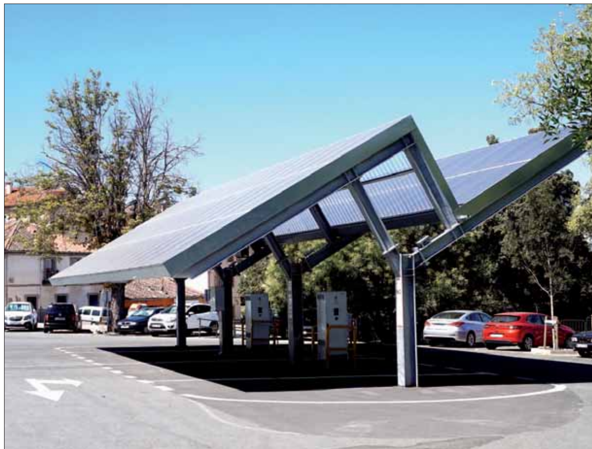
La electrolinera solar está ubicada junto al Parador y la Puerta de la Reina, en un lugar emblemático del municipio. / L. S.
