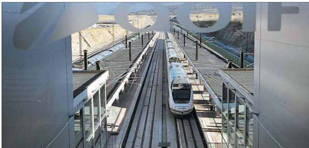
Vista de las vías de alta velocidad desde la estación de Segovia Guiomar. / ALBERTO BENAVENTE
