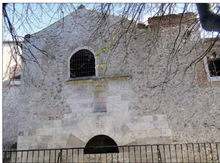
Fachada de la antigua capilla del Convento de la Concepción. / J. C. LL
