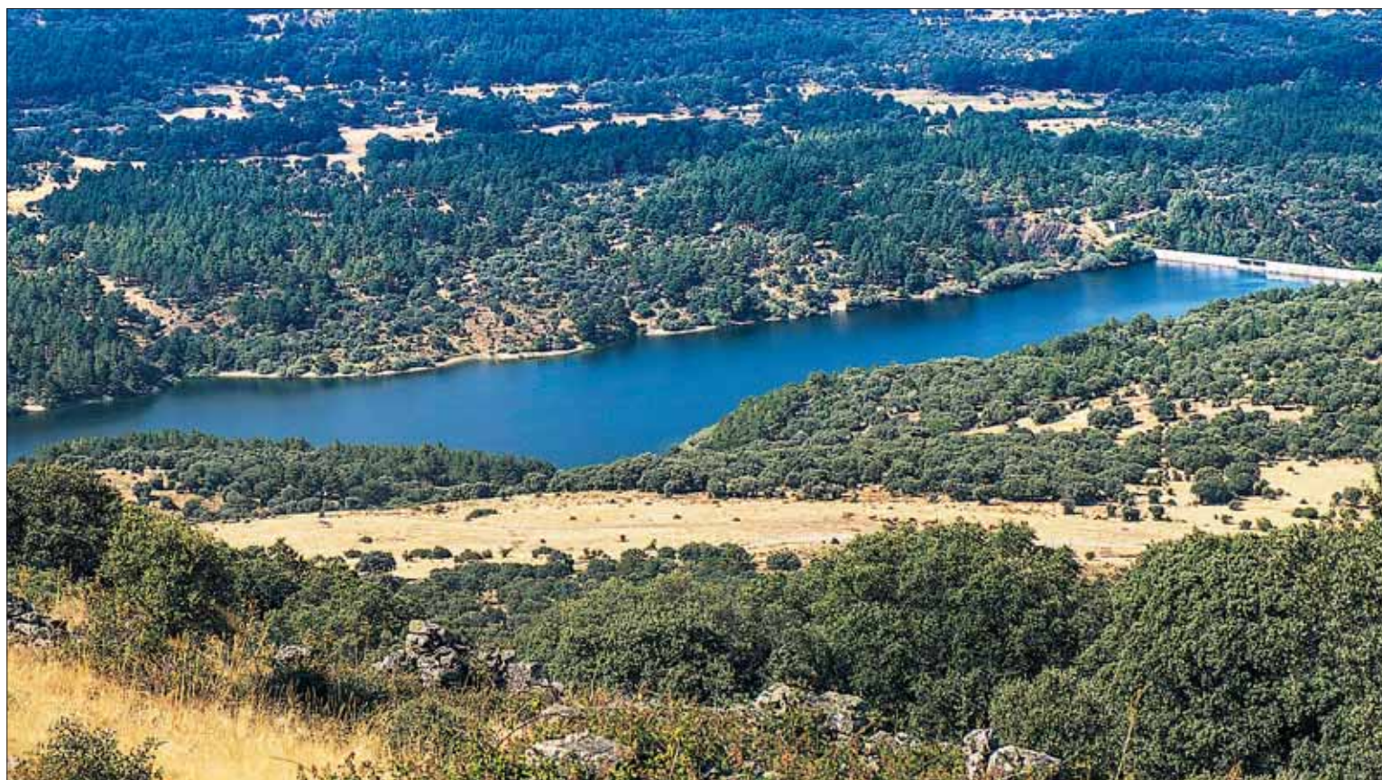
Presa de Puente Alta, en las inmediaciones de la entidad local menor de Revenga, cuya 'recrecida' parece descartada. / KAMARERO
