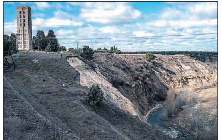
Vista del área donde se producen los deslizamientos. / KAMARERO
