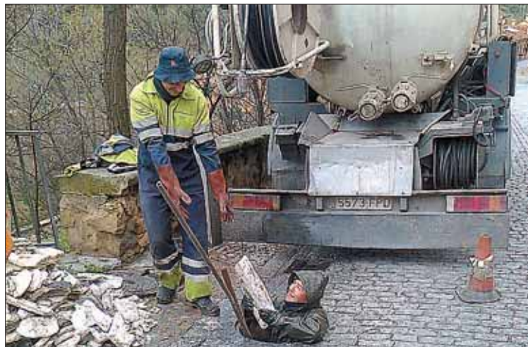
Una de las averías motivadas por residuos impropios en la red. / E. A.
