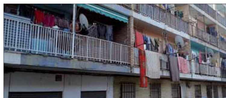
Fotografía del inmueble donde se cometió la agresión sobre la víctima. / E.P.
