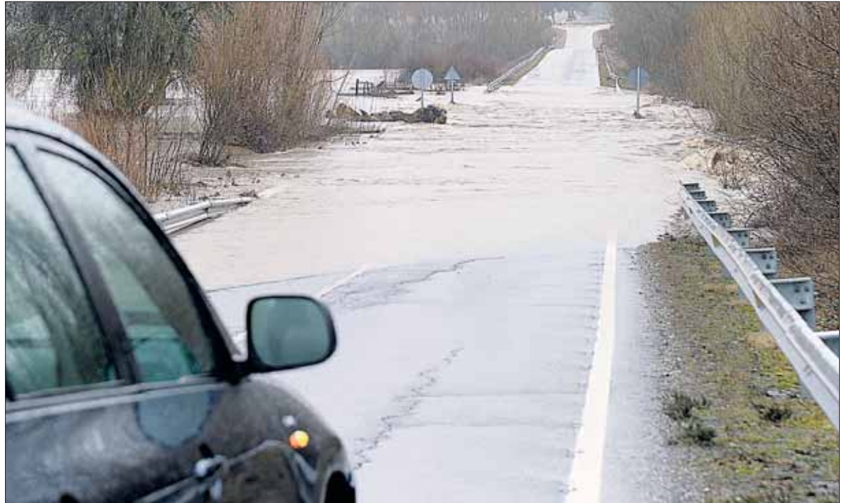
MARUGÁN. El puente de Allas, entre Abades y Marugán, fue cortado por una enorme balsa de agua. / KAMARERO
