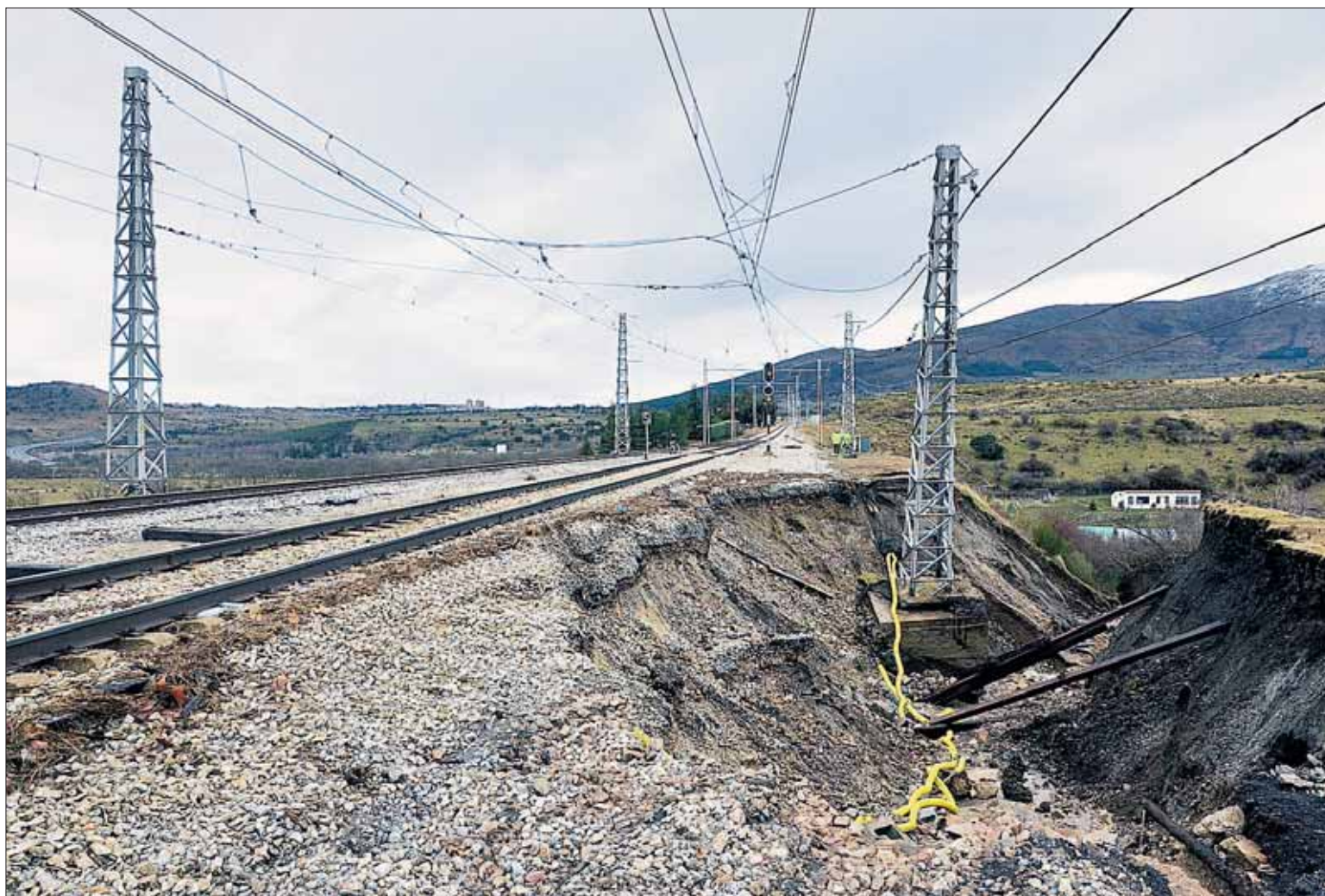
La fuerza del agua produjo un gran socavón en un terraplén cercano a la vía férrea sobre el que se había ubicado una columna de electrificación. / PEDRO MERINO
