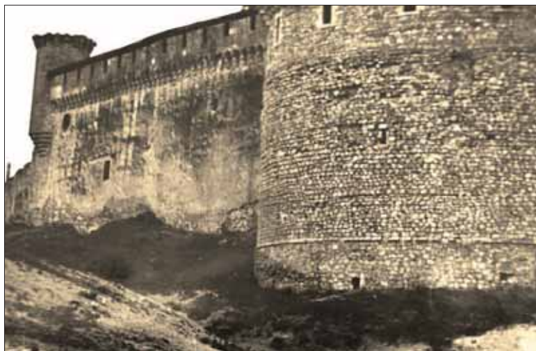
El ala oeste antes de desmontarse el adarve. / JUAN CARLOS LLORENTE
