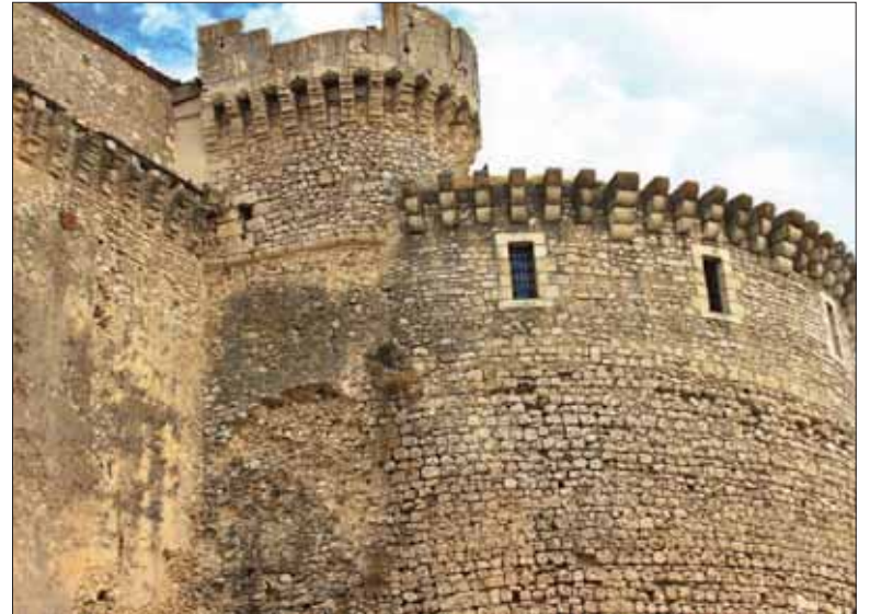
Evidente descarnado del muro de unión del torreón almenado y del cubo artillero. / J. C. LL
