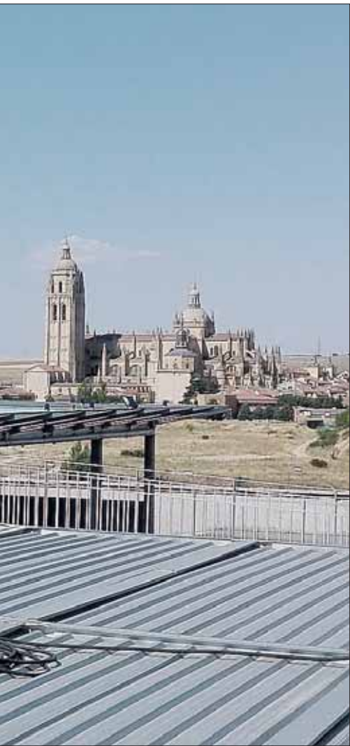
Helipuerto del Hospital General de Segovia. / F. D.
