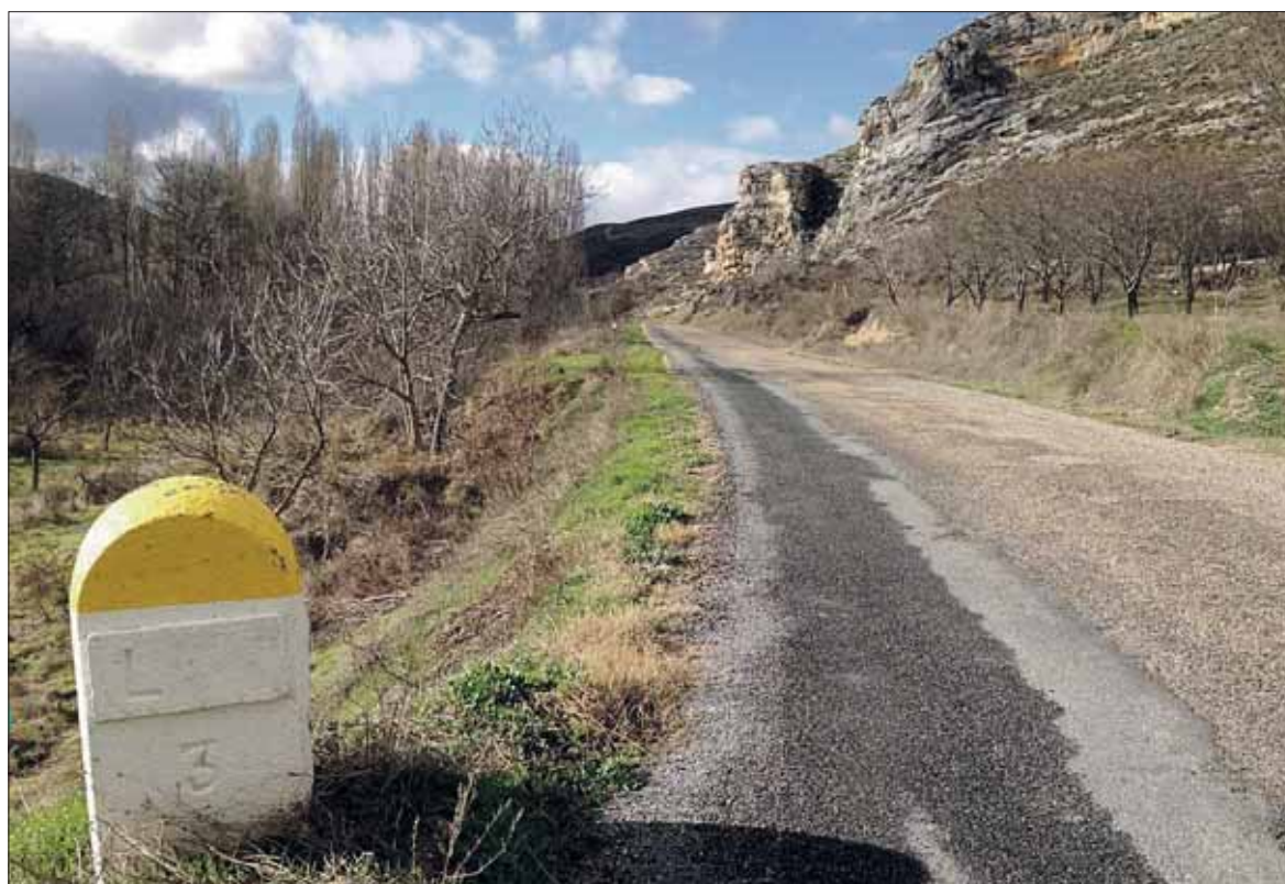
Uno de los bellos parajes por los que transita la carretera de Carrascal del Río al Valle de Tabladillo. / EL ADELANTADO
