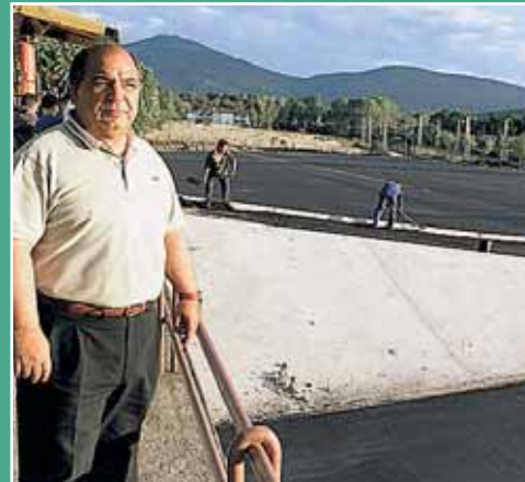
Muñoz, viendo las obras. / PEDRO LUIS MERINO
