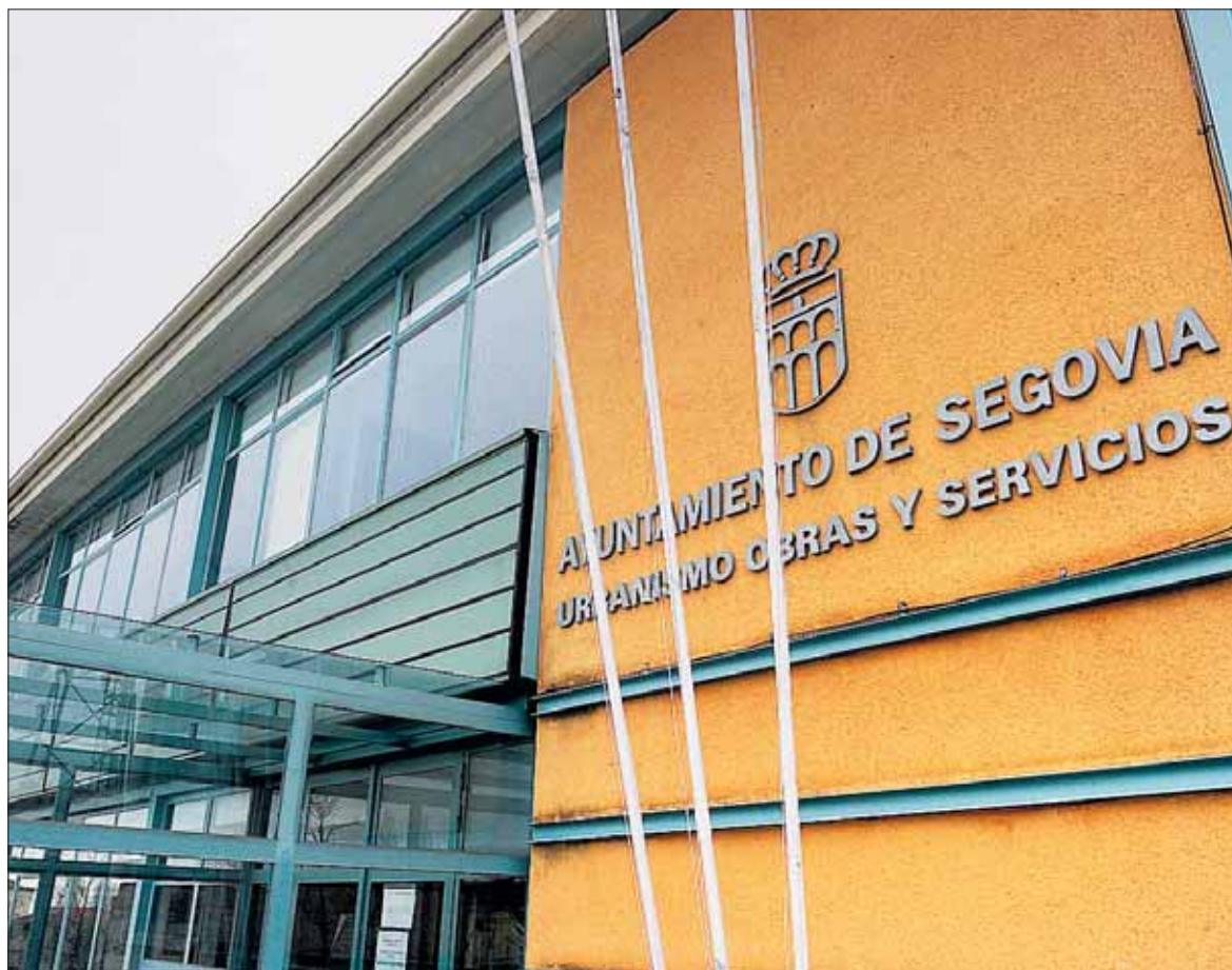
Sede del Servicio de Urbanismo del Ayuntamiento de Segovia, sito en el barrio de La Albuera. / KAMARERO
