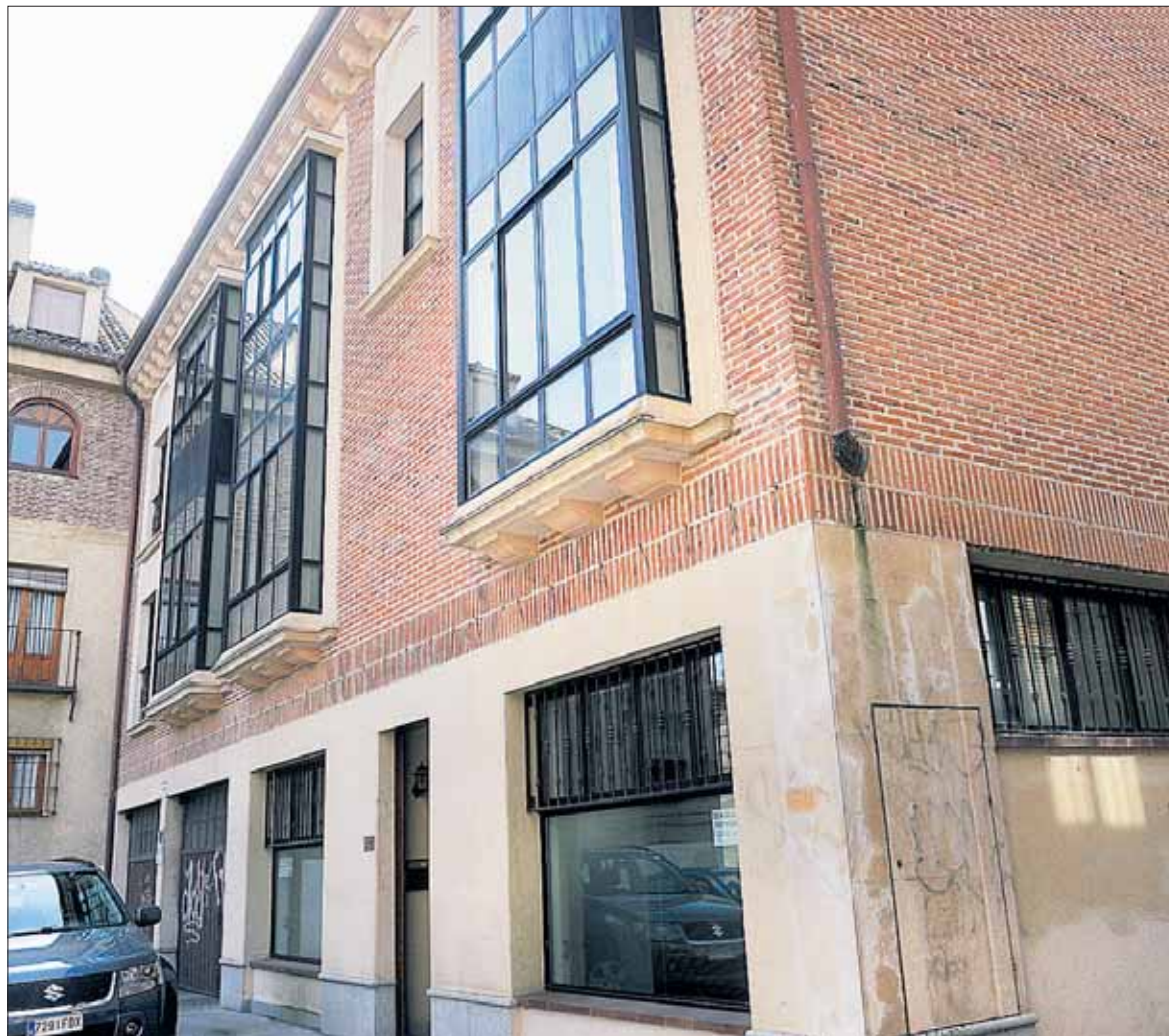
El polémico inmueble situado en la calle de La Parra está destinado a viviendas, un local y garajes. / KAMARERO
