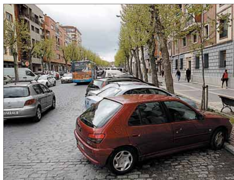
Las obras de la avenida de la Constitución siguen sin arrancar. / JUAN MARTÍN
