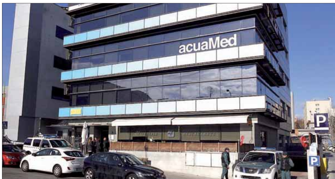
Sede de la empresa pública Acuamed, investigada por una presunta trama delictiva. / E.P.
