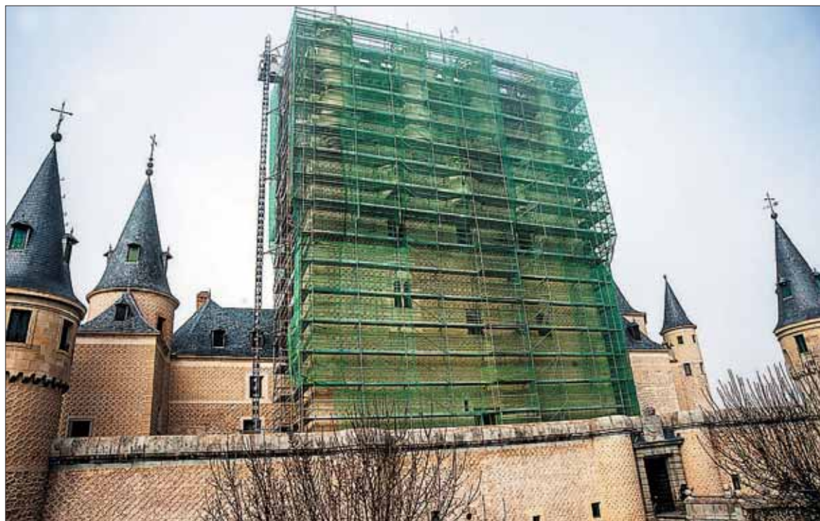
La obra busca frenar el deterioro de la coronación de la torre y mejorar el acceso interior a las visitas. / KAMARERO
