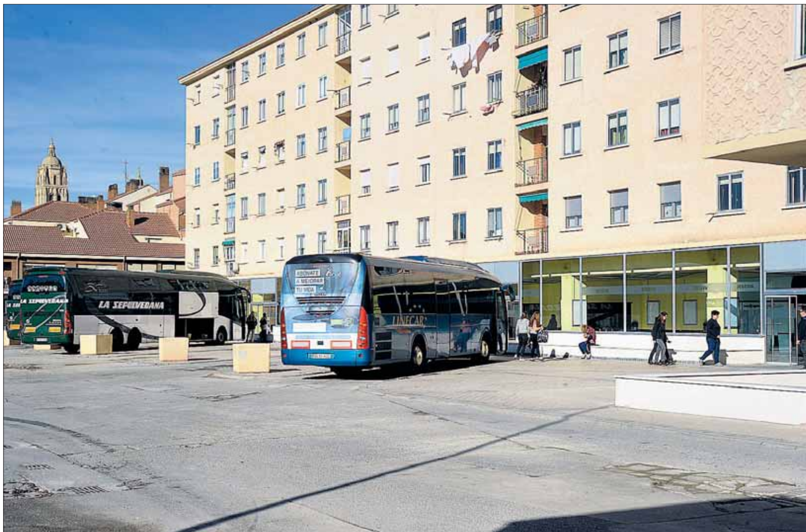
Campa de la terminal de autobuses, donde el pasado mes de noviembre finalizó la retirada de la marquesina que estaba adosada al edificio de viviendas. / KAMARERO
