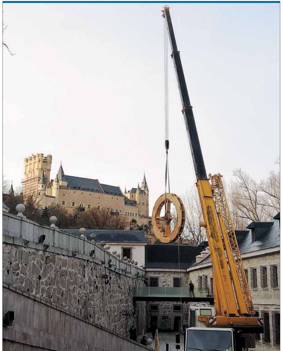
Una grúa eleva la rueda por encima del edificio herreriano para colocarla en la zona de canales. / EL ADELANTADO
