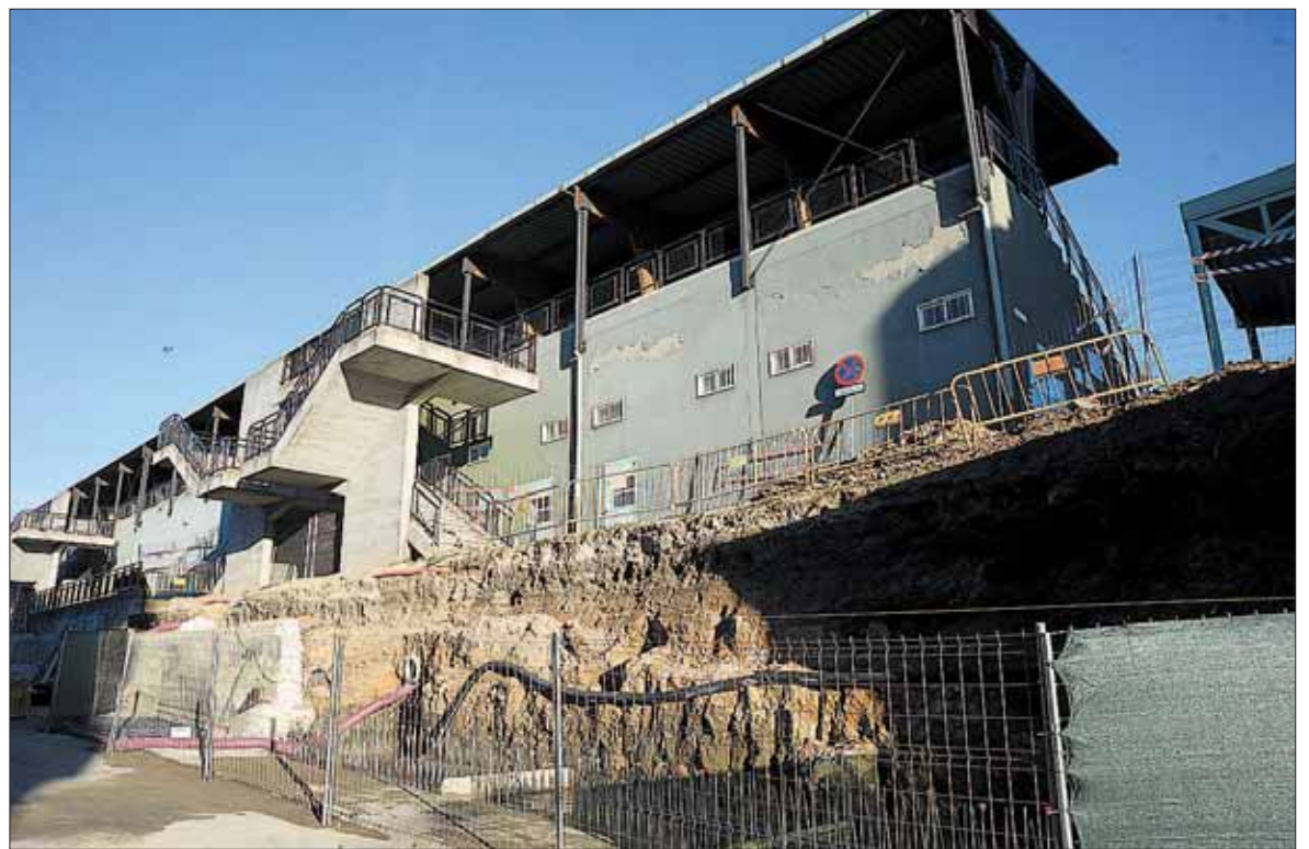
Estado reciente de las obras para construir la rampa de acceso a la ciudad deportiva de La Albuera. / A. C.
