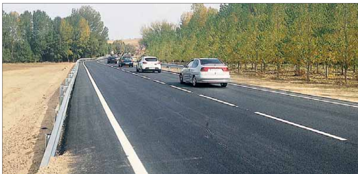
Aspecto que presenta la carretera que une la CL-605 con Hontanares de Eresma, tras las obras de mejora. / EL ADELANTADO
