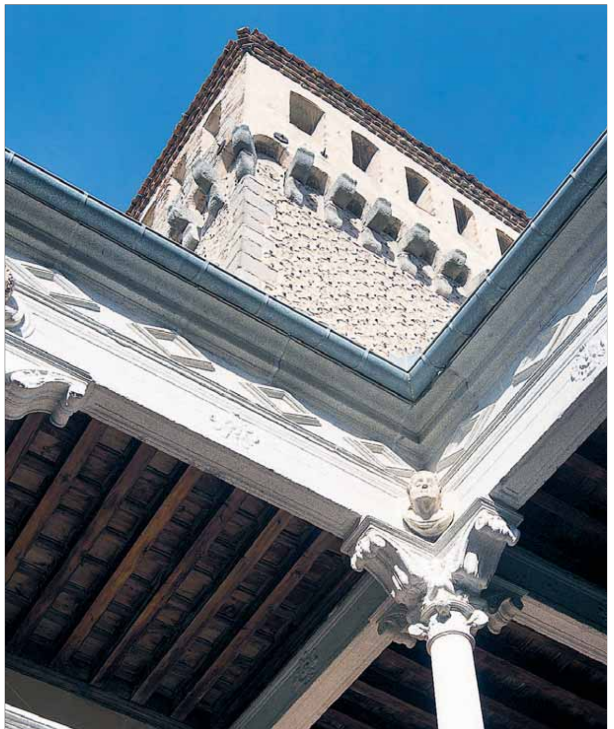
Imagen tomada desde el patio interior del edificio, donde se divisa la torre, que también será 'visible'. / KAMARERO
