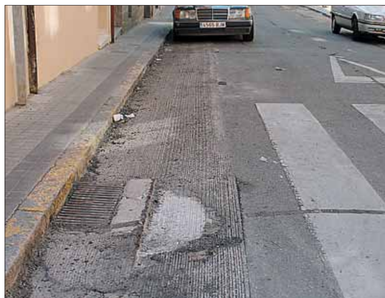
Este tramo de la calle San Cristóbal también se renovará este mes. / M. G.
