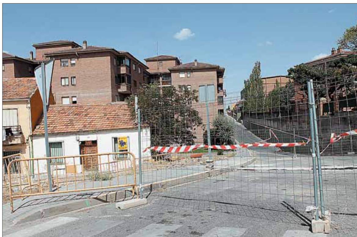
Punto de confluencia de la calle Los Silverios con la rotonda de la carretera de la CL 601, donde ya se ha actuado. / M. GALINDO
