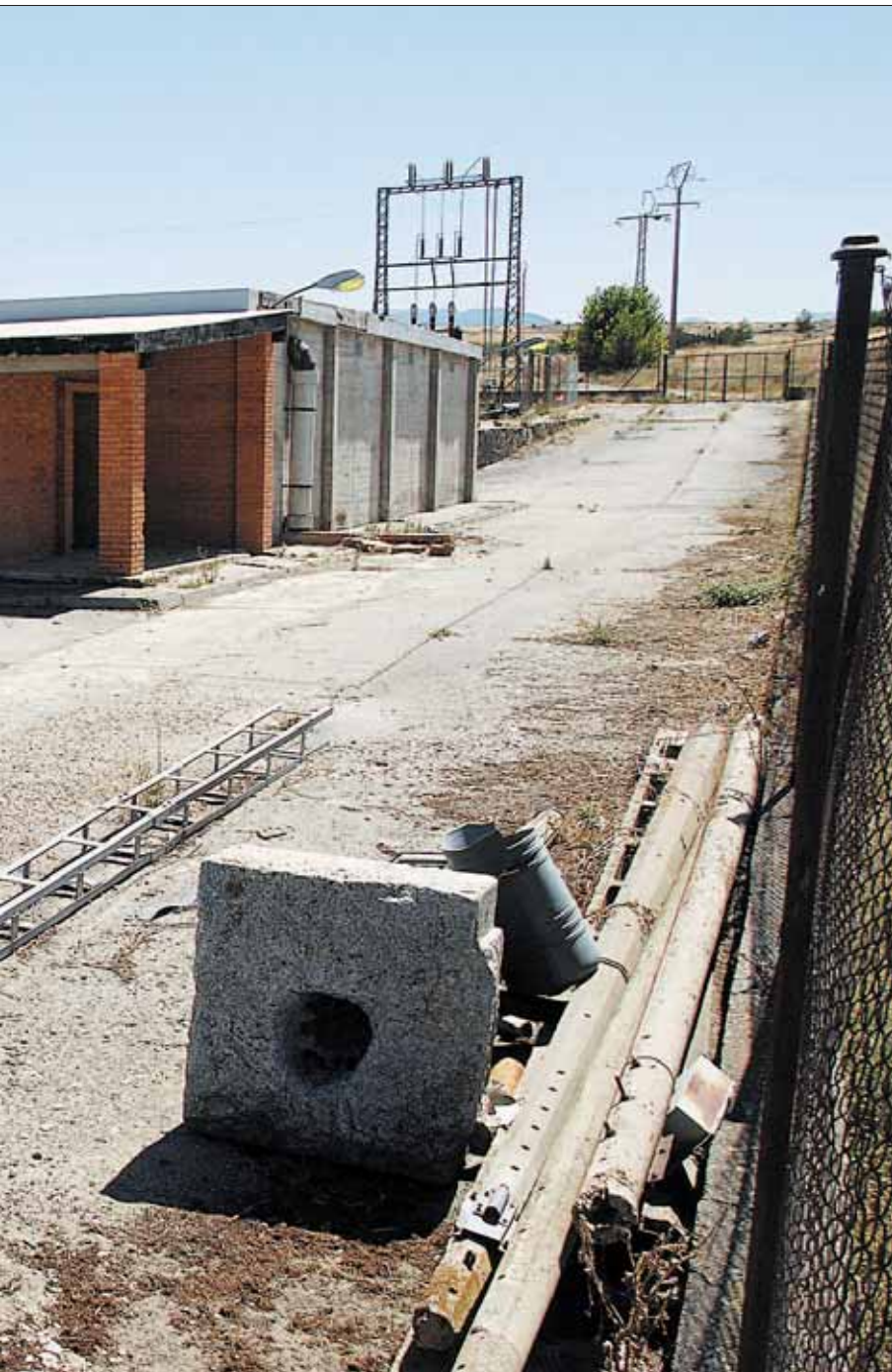
mejora de la bomba y la tubería. / JUAN MARTÍN
