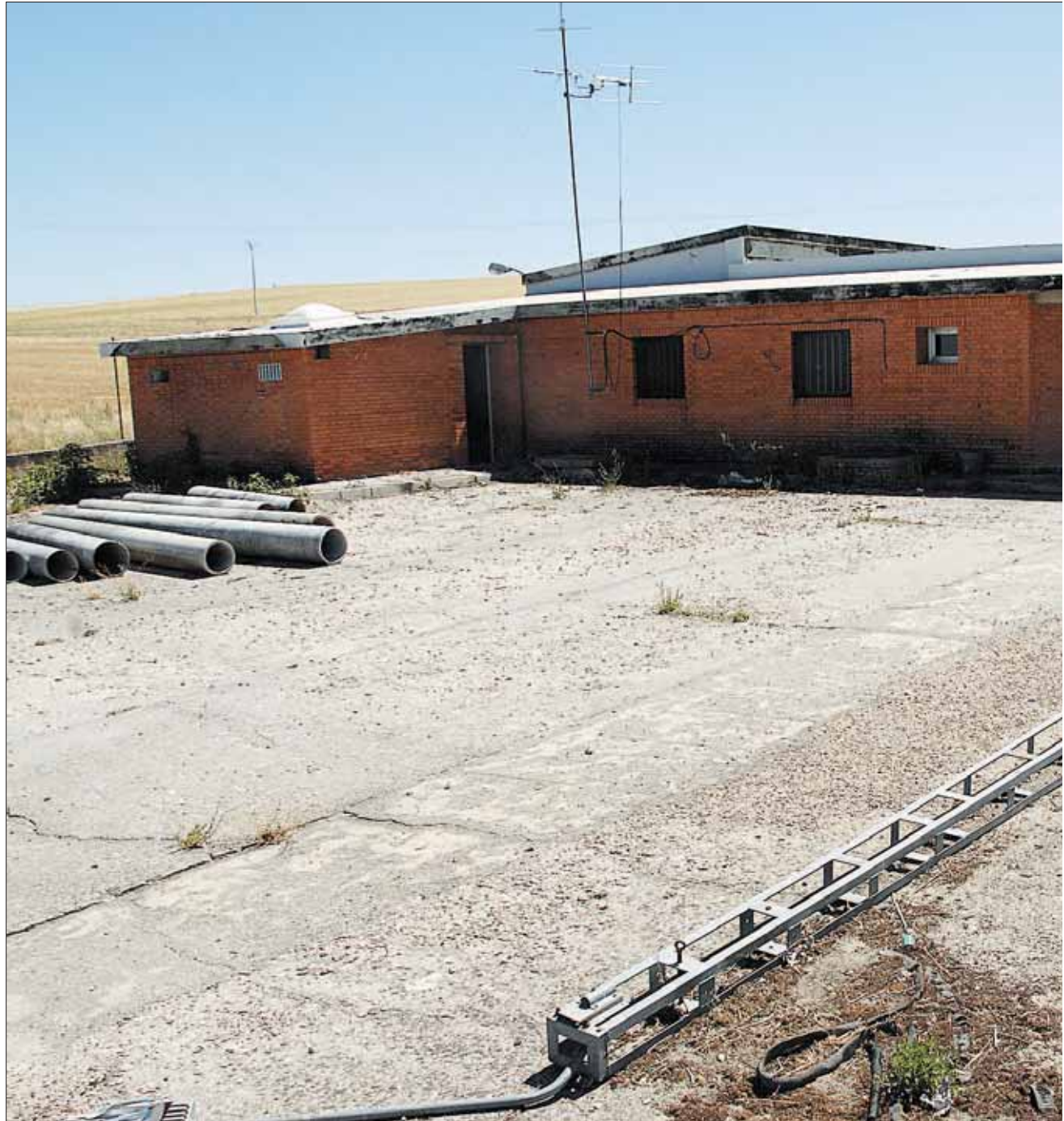
La zona de extracción de agua del acuífero de Madrona, donde esta semana se comenzará a trabajar en la excavación de un tercer pozo y la
