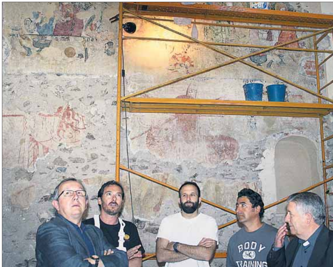
Responsables de la Junta y del Obispado visitaron ayer las obras de restauración de la iglesia de Pinarejos. / EL ADELANTADO
