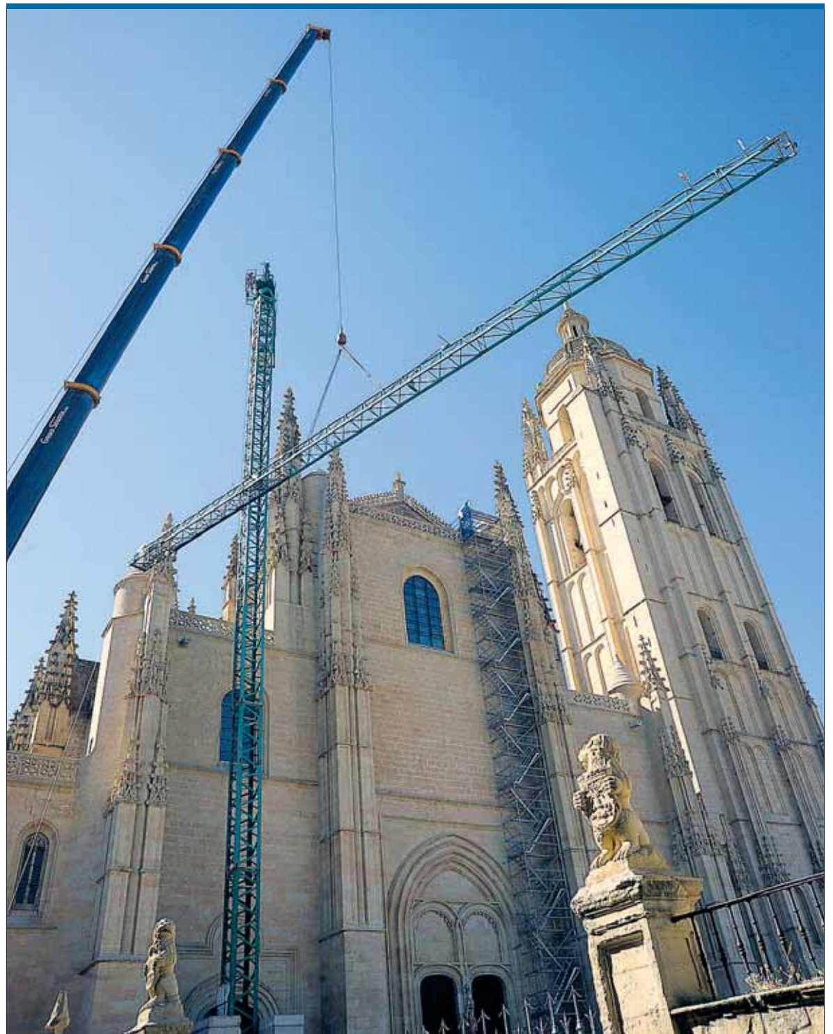
Momento en que se retiraba ayer por la mañana la grúa-torre de la zona del enlosado de la Catedral. / EL ADELANTADO
