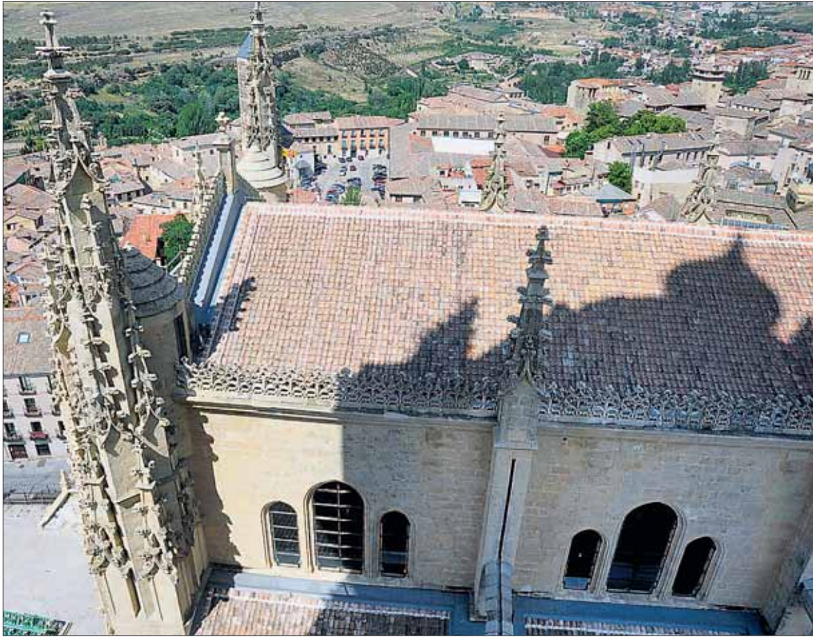
Las obras han permitido mejorar la estructura de algunos naves de la Catedral. / EL ADELANTADO
