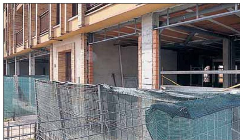
Foto de archivo del inicio de las obras en el local de Vía Roma. / JUAN MARTÍN
