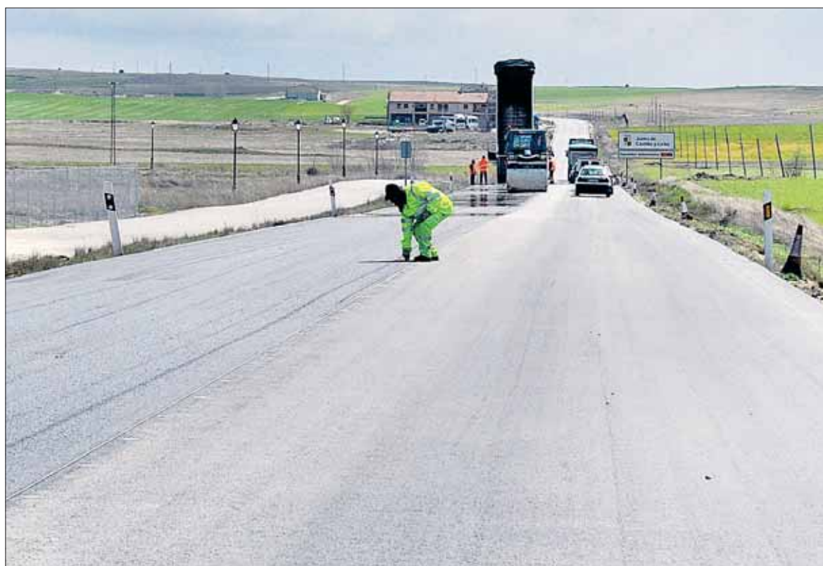
Personal de obras de la Diputación trabaja en una vía pública de la provincia. / EL ADELANTADO
