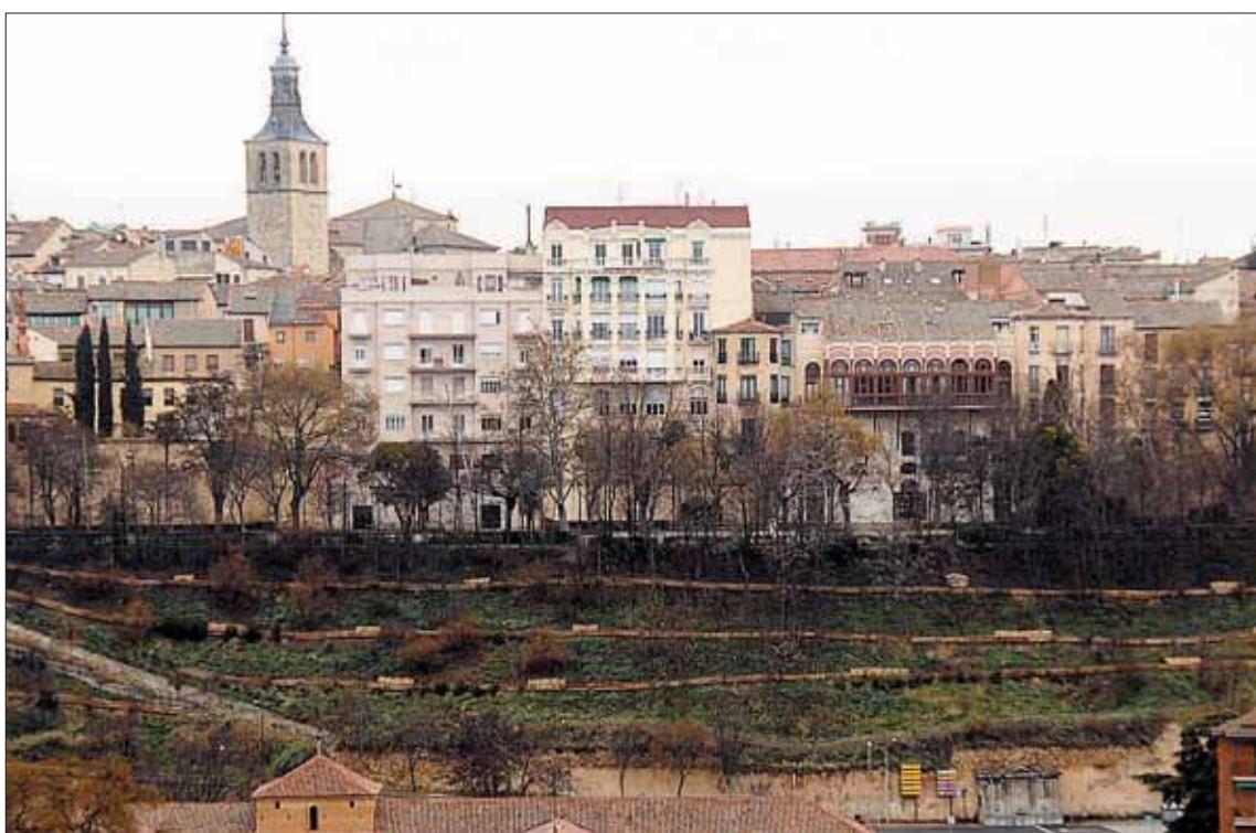
El contrato para la construcción del parking de Los Tilos fue suscrito hace más de seis años, en julio de 2008. / JUAN MARTÍN
