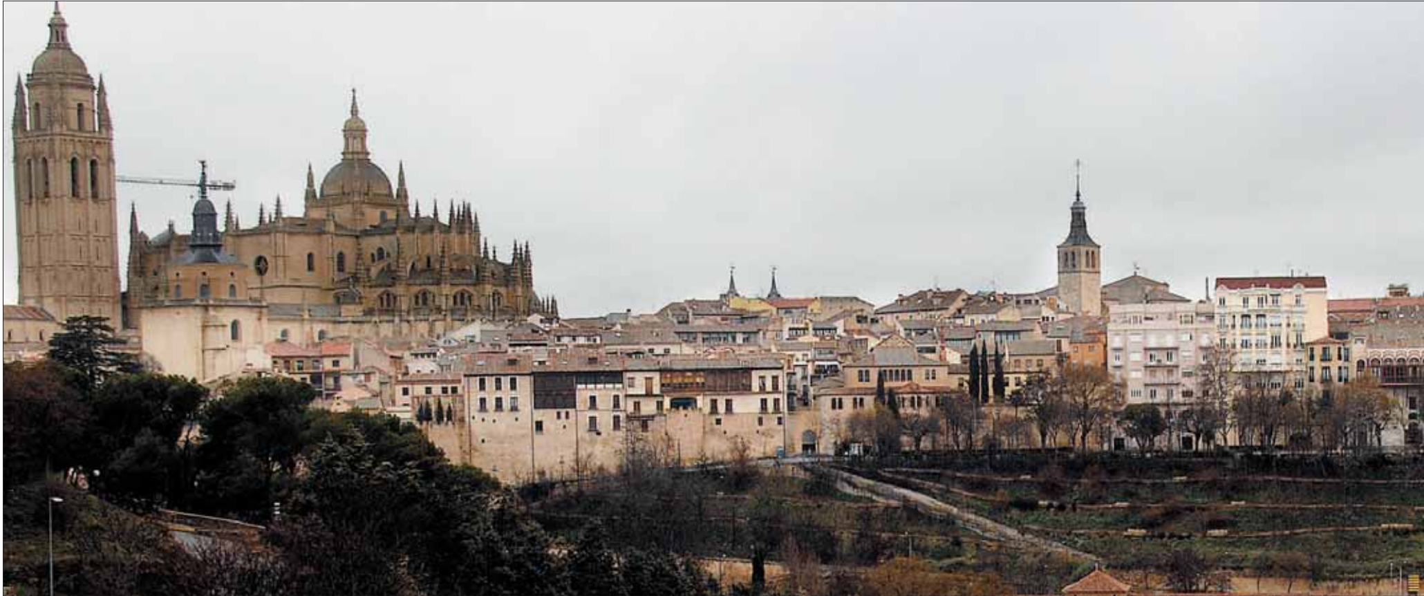
El PP considera que la ladera del Paseo del Salón supone un lugar estratégico para emplazar un parking, puesto que permitiría, mediante un remonte mecánico, un fácil acceso al recinto amurallado. Afirma, además, que la infraestructura
