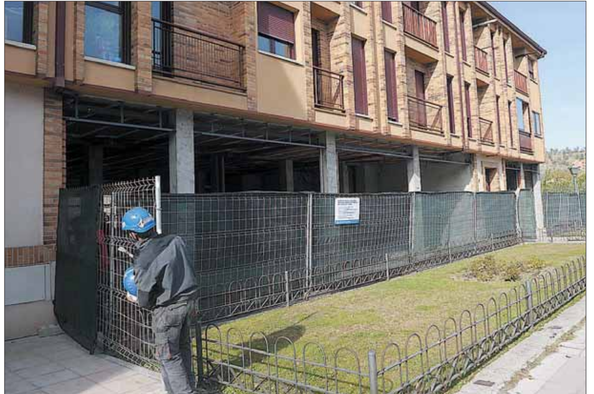
Los operarios trabajan en el acondicionamiento de los locales de Vía Roma desde el pasado mes de noviembre. / KAMARERO
