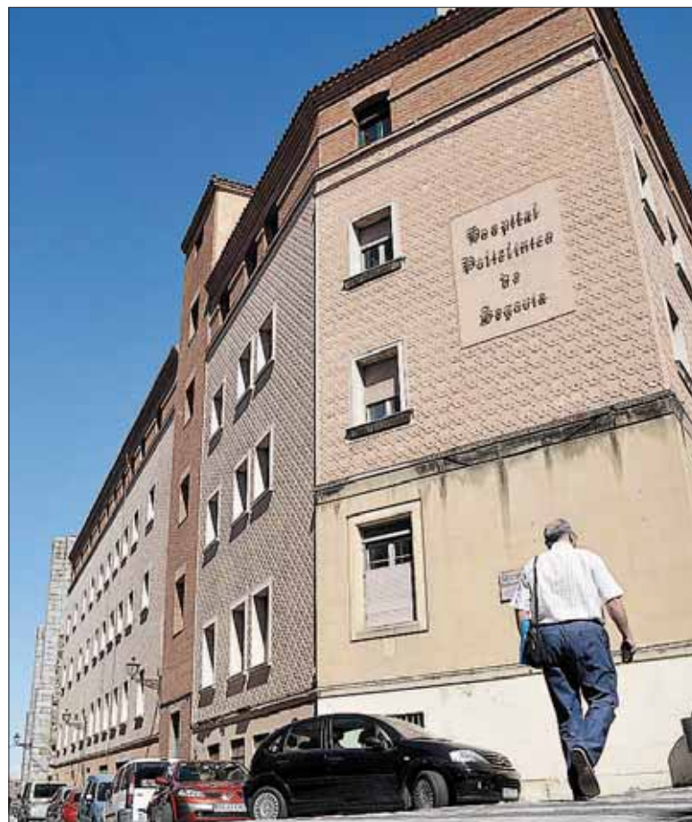
El edificio del Policlínico, cerrado desde 2008, tiene una superficie total construida de 6.584 metros cuadrados distribuida en cinco plantas y un sótano. / J.MARTÍN
