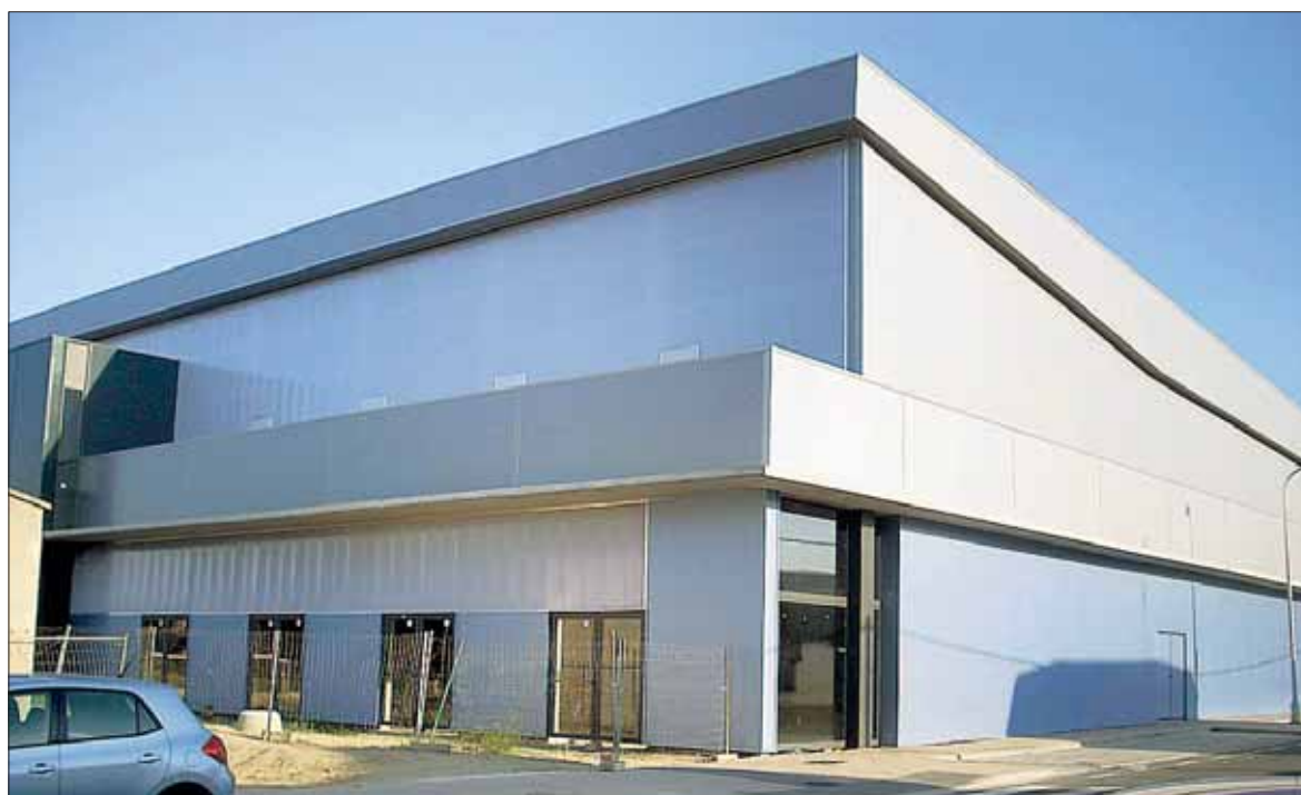
Estado actual del nuevo polideportivo en obras de Nava de la Asunción. / AMADOR MARUGÁN
