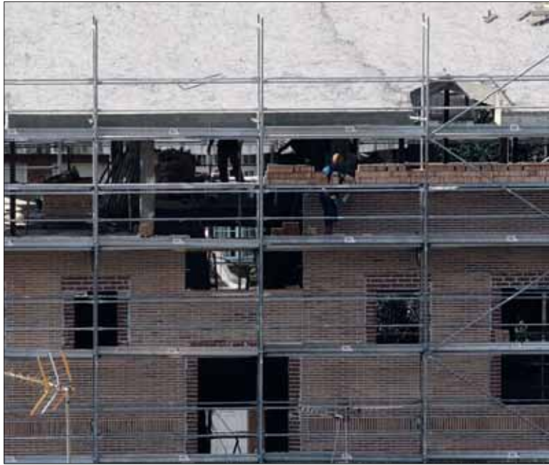
Imagen de archivo de unas viviendas en construcción. / EUROPA PRESS
